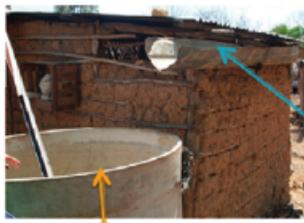
Tanques de almacenamiento de agua fabricados en asbesto y cemento.
